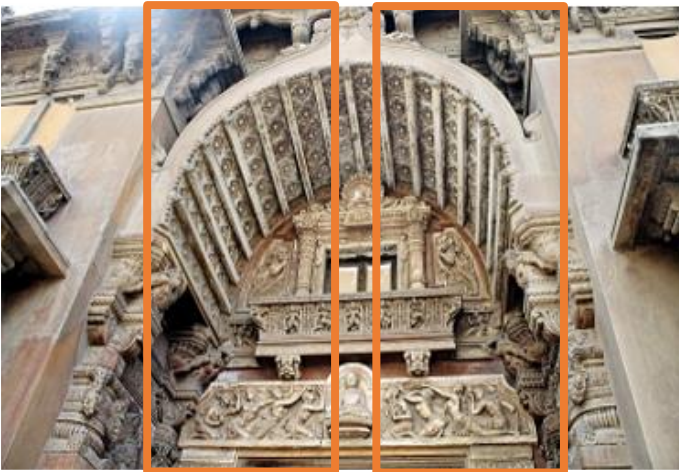
صورة ( 17 ) المدخل الرئيسي لقصر البارون تتميز بالتماثل وتأكيد المدخل بحائط زخرفي يخترقه العقد " مدخل مؤكد بعقد "
